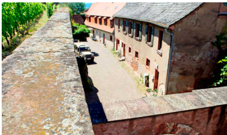
Hofidylle am alten Gefängnis: Der Platz am Fuß des Schlossbergs wird eingerahmt von Kerkermauern, einem Eingangstor aus Stein und der Kirchenmauer.
